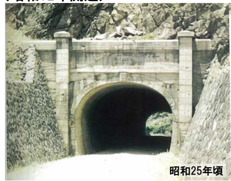
①初代トンネル:座津武トンネル (昭和12年開通)
