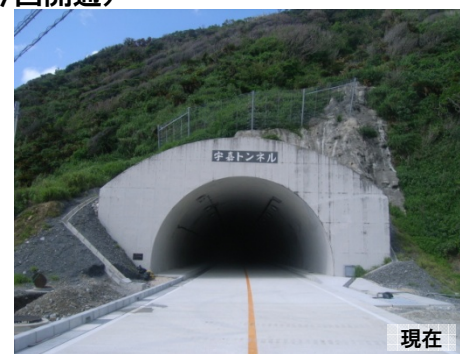
③3代目トンネル:宇嘉トンネル (今回開通)
