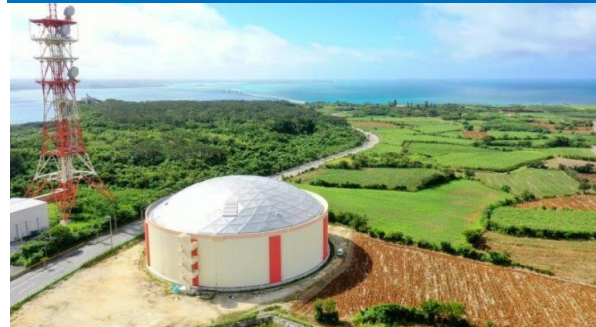
国営かんがい排水事業 牧山ファームポンド
