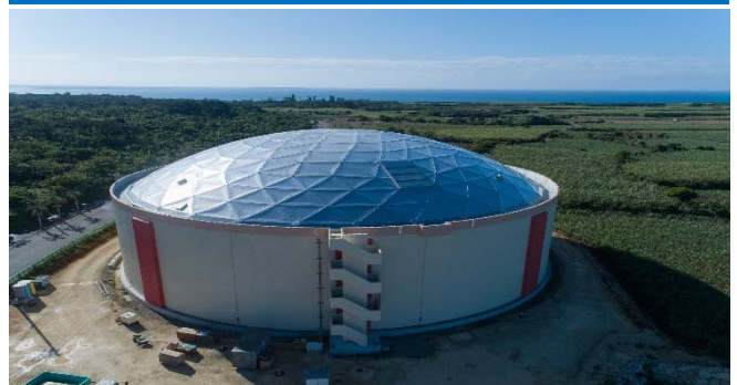
国営かんがい排水事業 牧山ファームポンド
